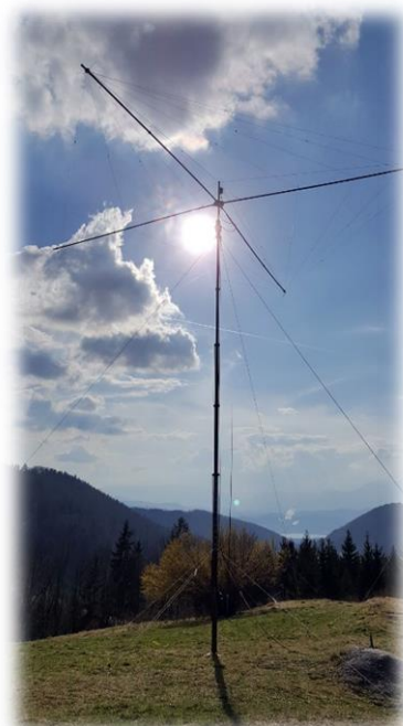
Teleskopski stolp z anteno spiderbeam in zunanji del preklopnika
