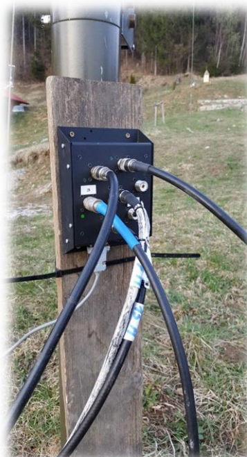
Teleskopski stolp z anteno spiderbeam in zunanji del preklopnika
