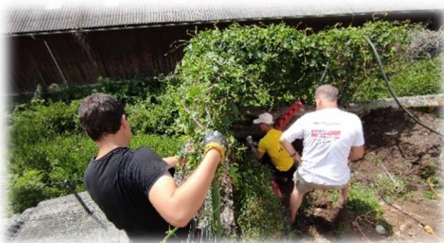
Vrtanje skozi škarko in priprava kablov (novih/starih) za vezavo ter luknje za električno omarico
