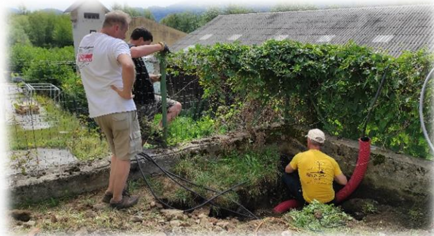
Vrtanje skozi škarko in priprava kablov (novih/starih) za vezavo ter luknje za električno omarico
